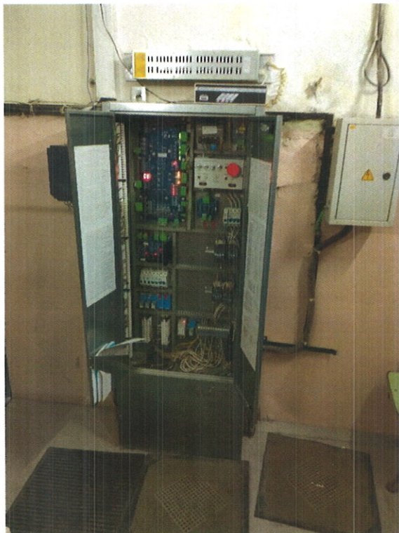
В ходе работ
