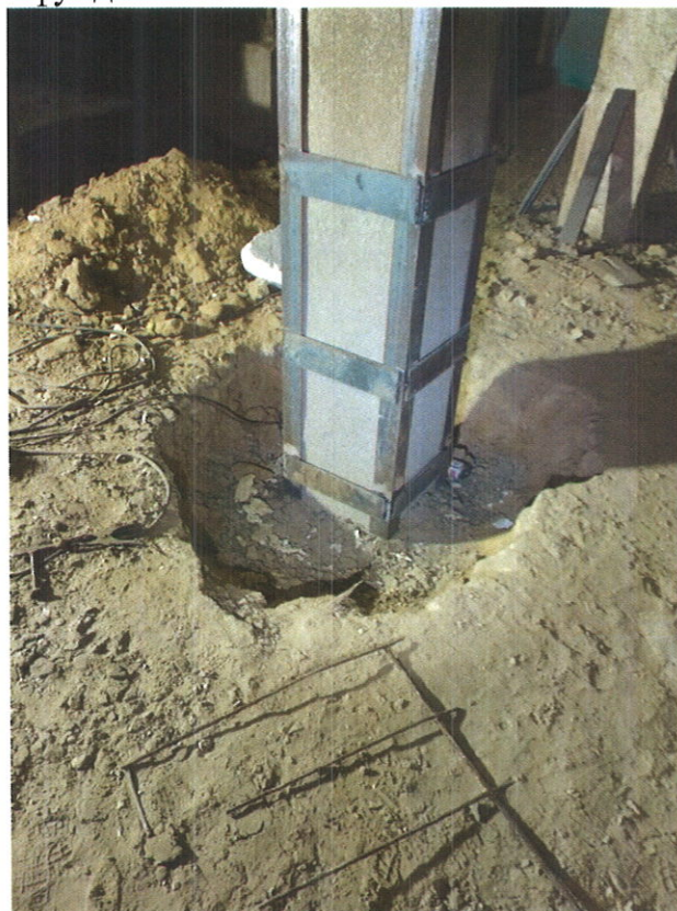
В ходе работ
